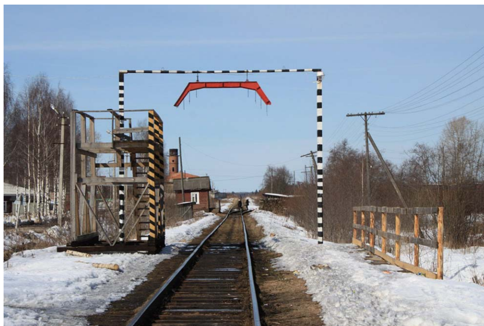
Рис. 1. Габаритные ворота [1]
